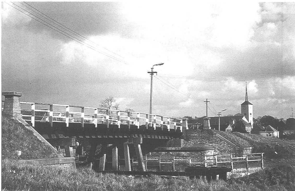
Op vrijdag 24 mei 1940 werd samen met de kerk ook de brug over het kanaal opgeblazen. Deze foto van de voorlopige brug werd gemaakt halweg de jaren zestig.
