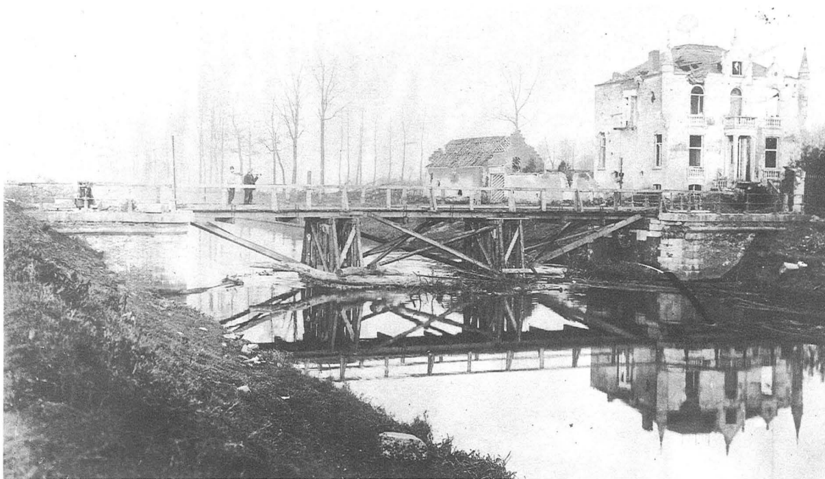
Tijdens de gevechten in oktober-november 1918 werd de ophaalbrug over het Schipdonkkanaal vernield. Een houten noodbrug maakte het verkeer tussen de Heirenthoek en Landegemdorp weer mogelijk, maar de pijlers van de brug maakten de scheepvaart voorlopig niet mogelijk. Rechts op de achtergrond de vernielde “Villa Pia”.
